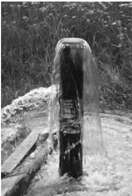
Puits jaillissant non maîtrisé
