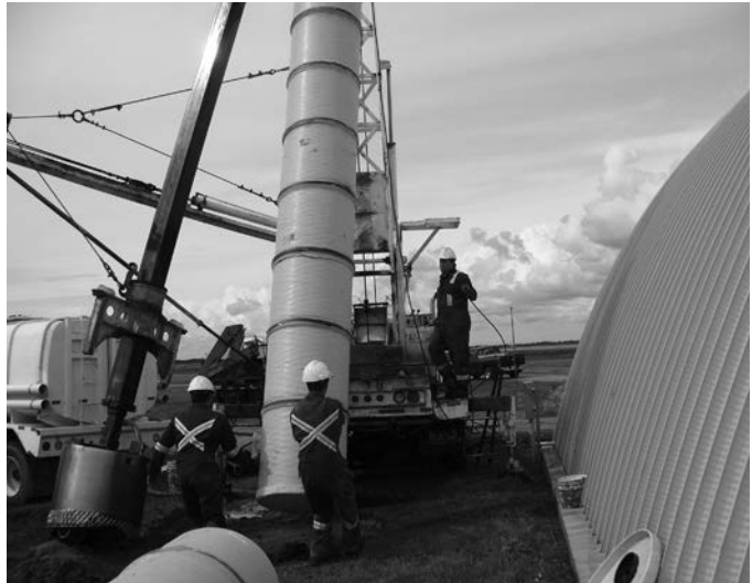
Construction d'un puits foré
