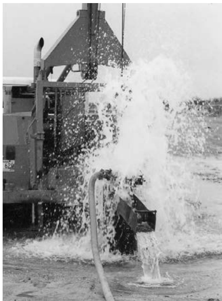
Aménagement d'un puits
