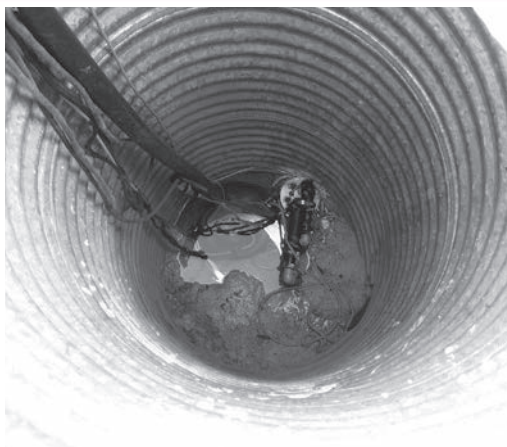
Puits creusé dans une fosse.
